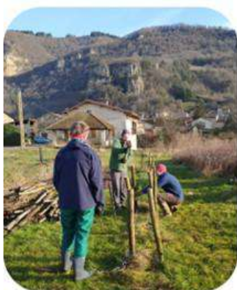
Installation des piquets
