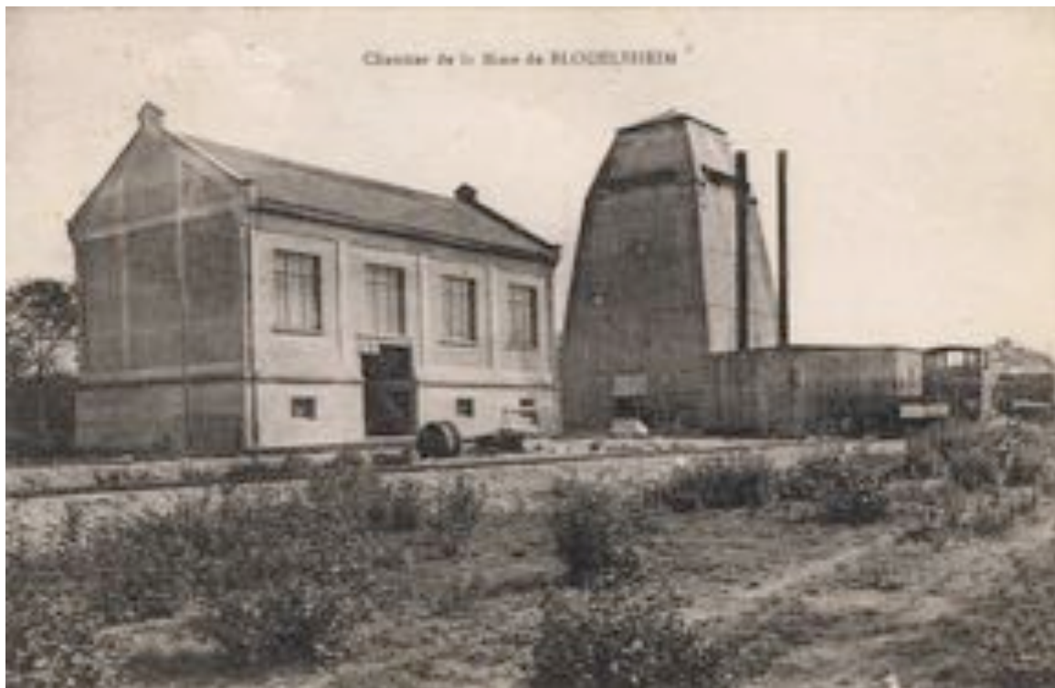
Fig 13 Bâtiment de la machine d'extraction et chevalement du puits N° 1 Nord. Lors du fonçage l'avancement journalier était d'environ 0,70 mètre. Le puits était congelé, foncé puis revêtu d'un cuvelage en fonte.
