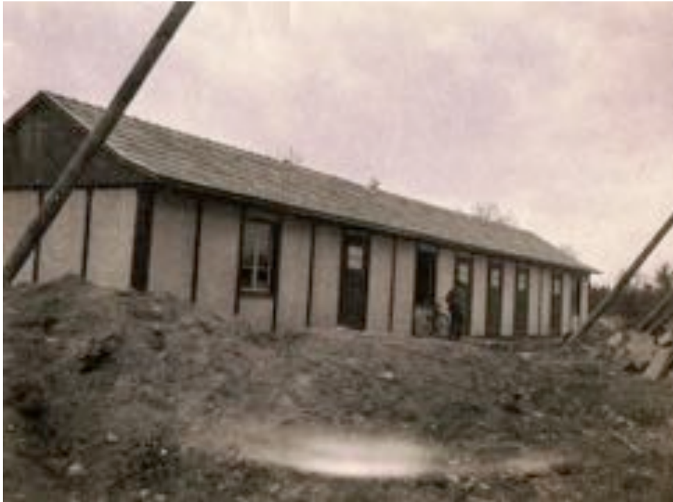
Fig 4 : Construction des bureaux et des annexes.
