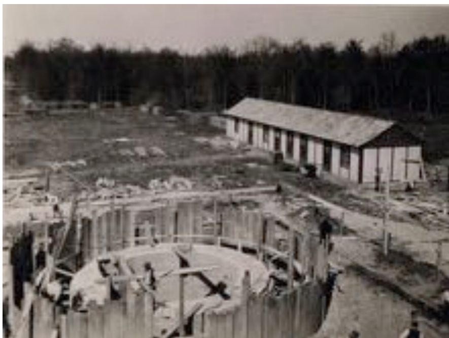
Fig 11 et 12 Creusement et coffrage de la tête du puits N° 1
