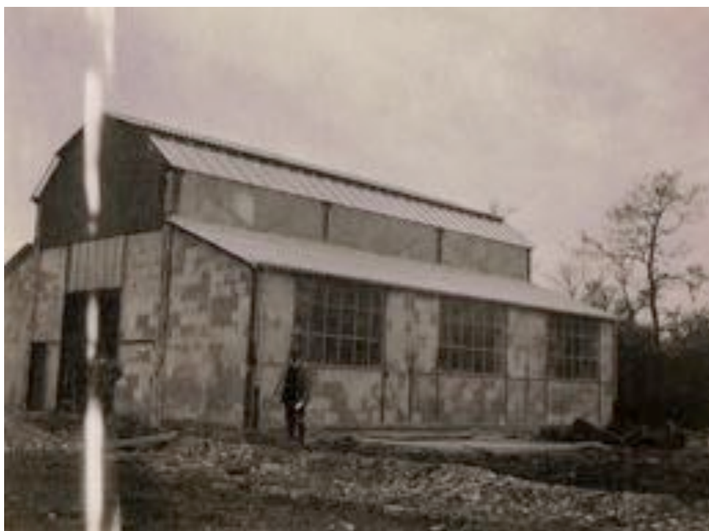
Fig. 15 et 16 : Construction du bâtiment de la machine d'extraction et des ateliers du Puits N° 2 SUD. La machine d'extraction électrique est du type « LEONARD » équipé d'une poulie « KOEPE ». L'effectif de la Compagnie était de 151 personnes.
