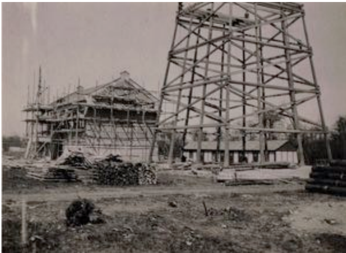
Fig 10 : Construction des infrastructures de surface du puits n° 1 Nord
