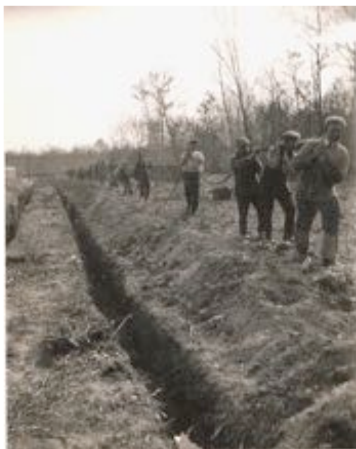
Fig 14 Pose du câble souterrain d'alimentation électrique du site minier.
