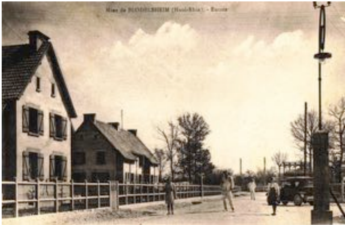
Fig 7 : En 1929 : construction d'une cité de 12 logements pour les familles des mineurs. Sur cet emplacement se trouve actuellement le parc de loisirs du « PONEY-PARC ».
