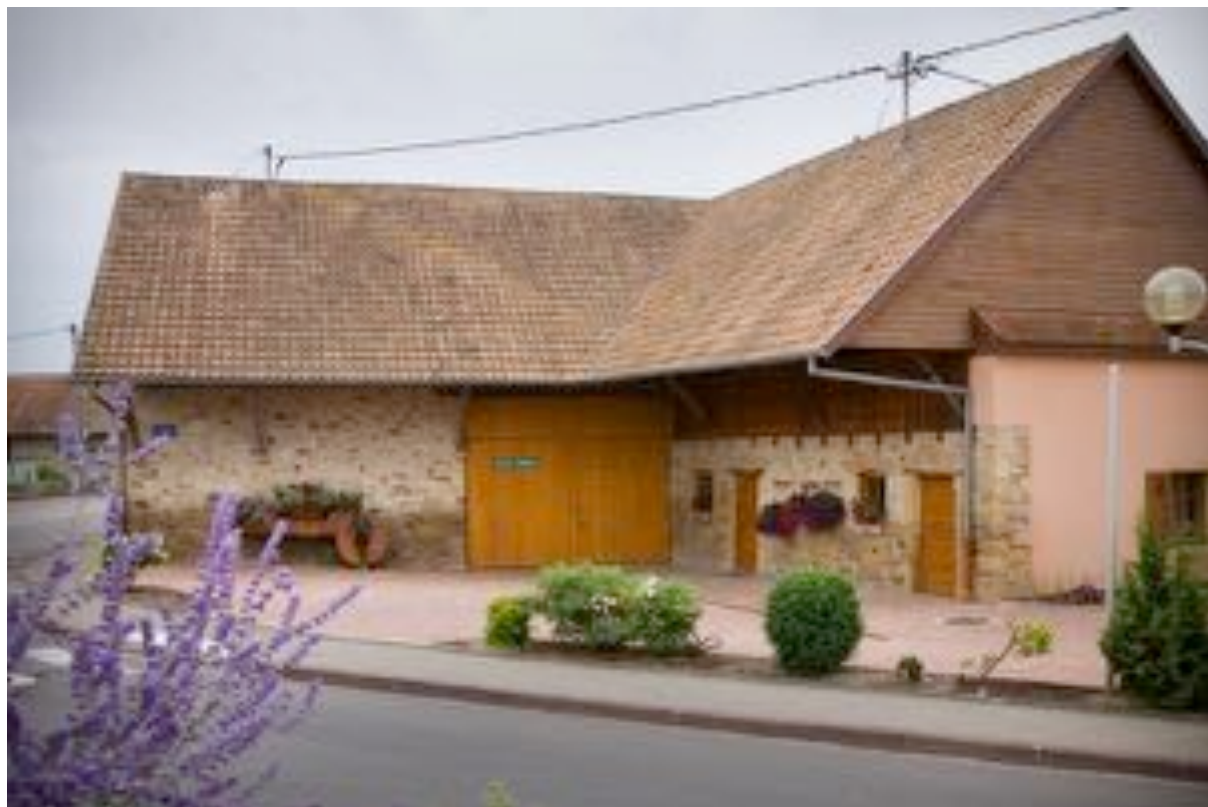
Hangar communal de Rustenhart (clichés d'Antoine Linder, Studio A)
