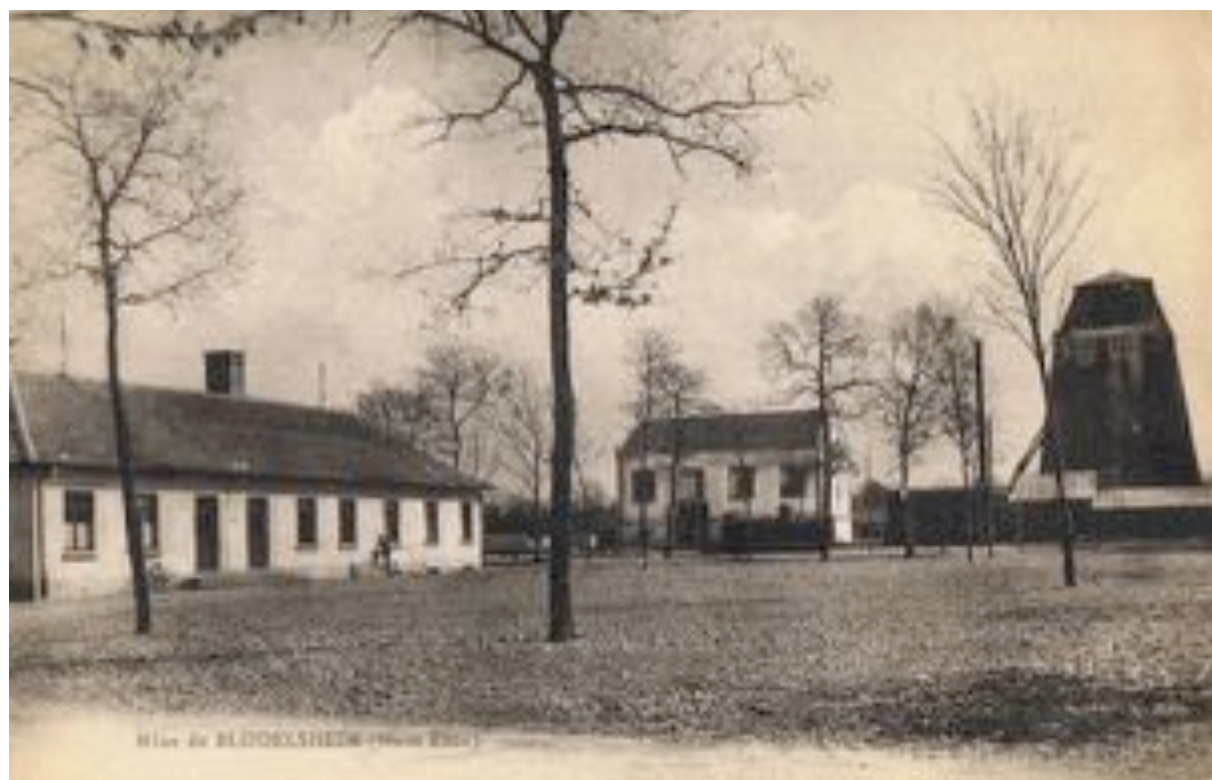
Fig. 20 : Site d'exploitation du puits N° 1 Nord avant sa démolition en 1949.
