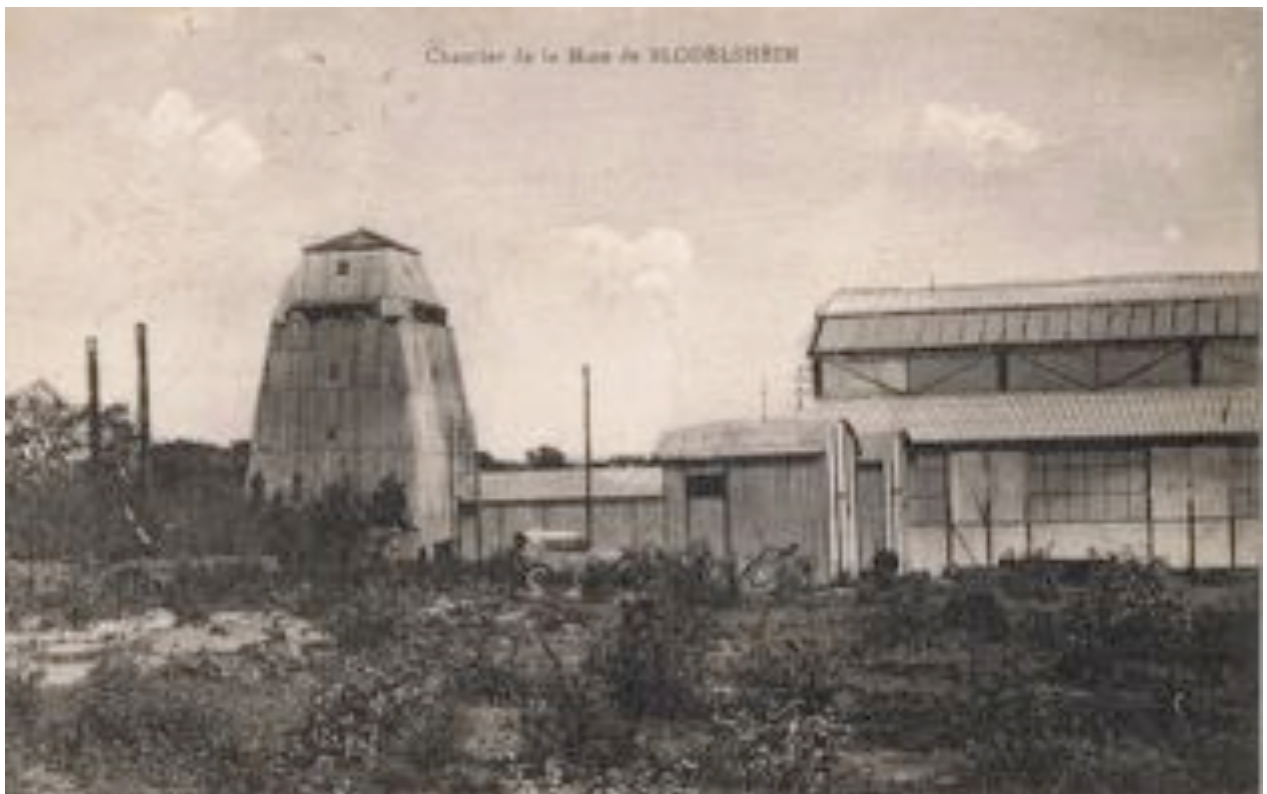
Fig. 18 : Chevalement et bâtiments techniques du puits N° 2 Sud.
