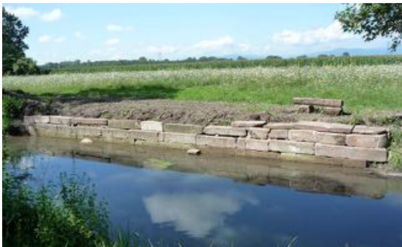
Les vestiges du moulin tels qu'ils se présentaient en septembre 2012.
