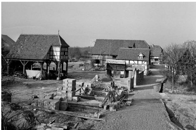
Figure 10. Le porche de la cour est en place et les fondations de l'habitation sont posées (1983)
