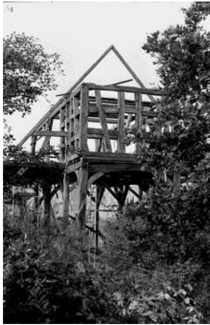
Figure 7. Progression du montage de l'ossature
