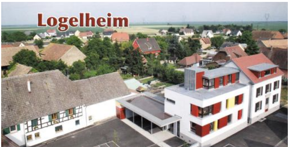
Fig 2 : La nouvelle école de Logelheim.
