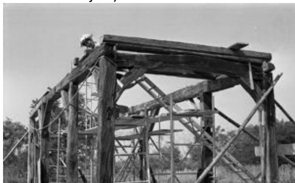
Figure 6. Les poteaux sont dressés sur le chantier d'Ungersheim
