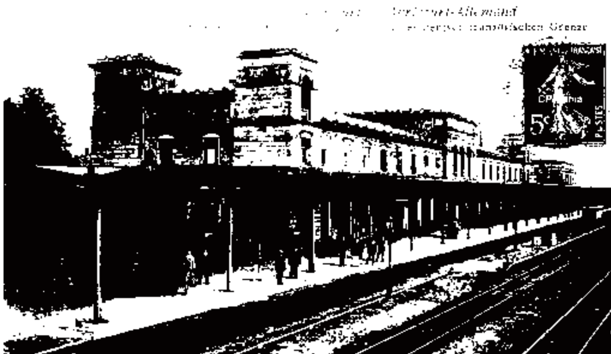
A la gare frontière d'Avricourt, les passagers descendaient du train, franchissaient les contrôles de police et de douane allemands, attendaient la mise à quai du train allemand (compagnie Elsass-Lothringen) qui partait en circulation à droite pour Sarrebourg et Strasbourg.
