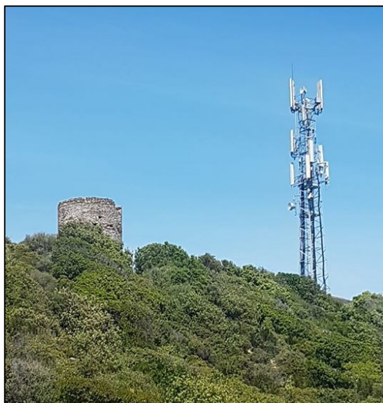
Exemple d'antenne dans le Cap Corse.
